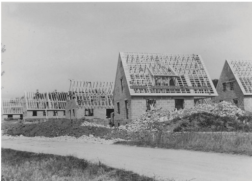
Die Häuser des 2. Bauabschnitts im Rohbau
