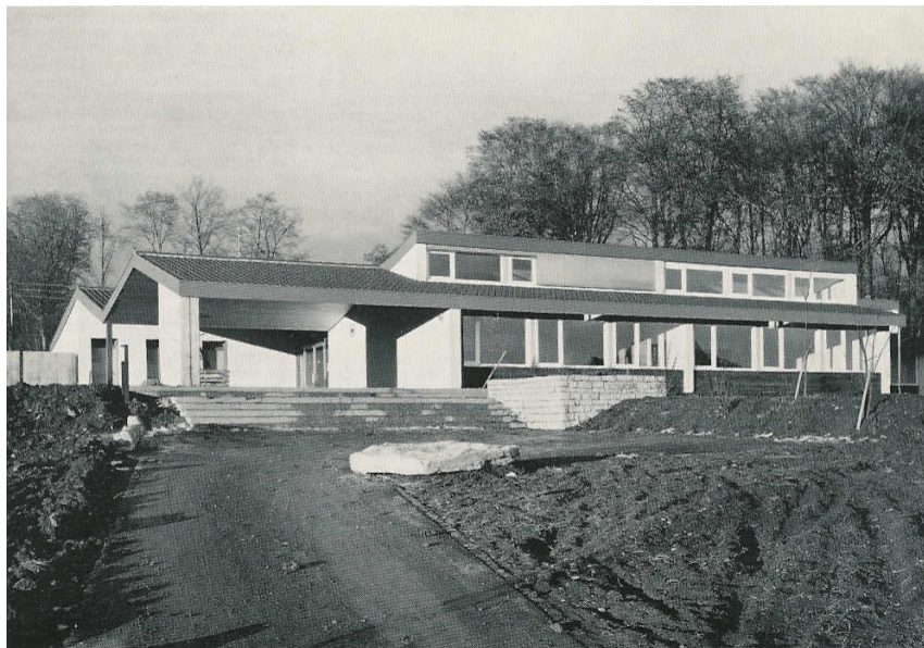
Die Grundschule in Hochwang. Nach dem Schulentwicklungsplan ist es beim ersten Bauabschnitt geblieben
